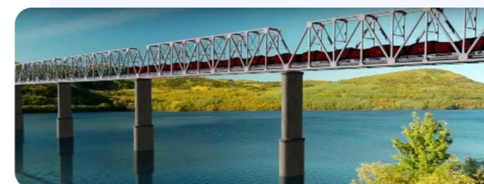
Мостовой переход через реку Тулома
