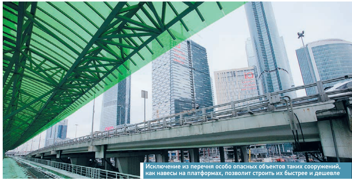
Исключение из перечня особо опасных объектов таких сооружений, как навесы на платформах, позволит строить их быстрее и дешевле
